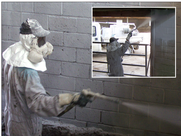
Figura 5: Ejemplo de encalado de un establo con lechada de cal. La lechada de cal puede también aplicarse por cepillado u otras técnicas (Bélgica).
