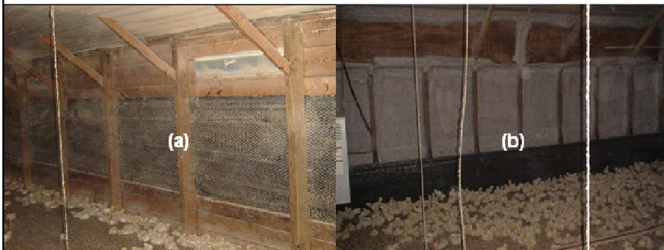
(a) Pared con cortina (R-1) convertida a pared sólida (b) con aislamiento de espuma de poliuretano con un R-8
