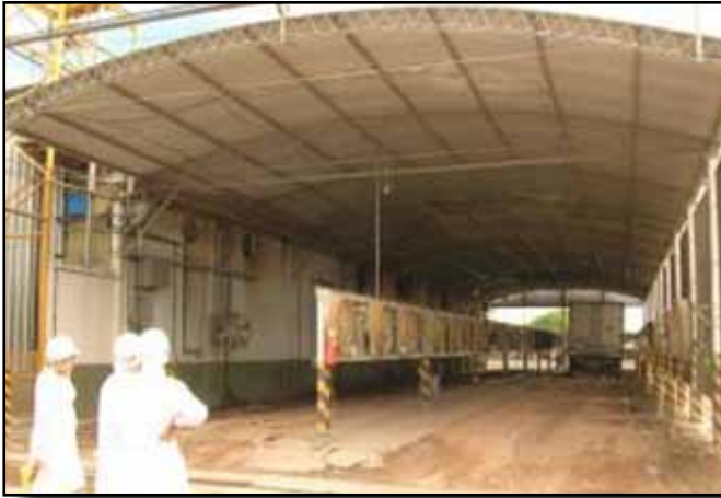
Figura 5: Un área de espera en una planta de proceso.
